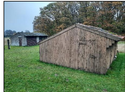
Figuur 11. Impressie schuren op onderzoekslocatie, kijkrichting noorden.
