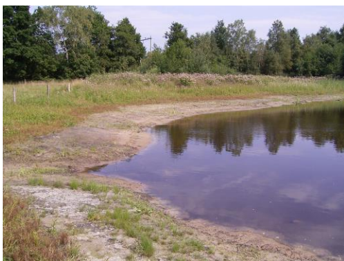
Geleidelijk talud en verwerking van de grond in een landschappelijke verhoging
