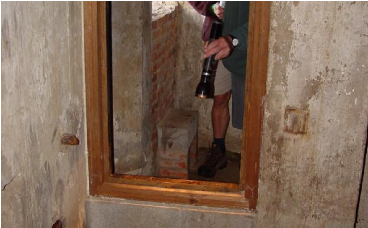
Frame binnendeur bunker.jpg
