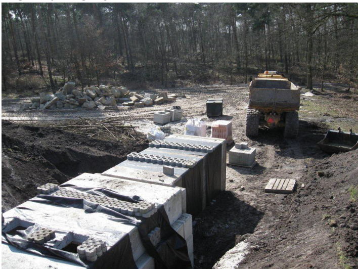
Figuur 9: Afdekken met worteldoek houdt instromen van zand tegen, maar ook deels muizen. (Hier worden alleen de naden afgedekt).
