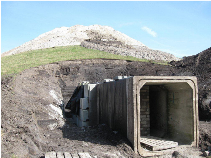
Figuur 5: Zandbed achter de kelder, vergemakkelijkt het afdekken.
